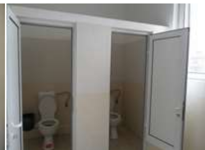
真新しくなった衛生施設
