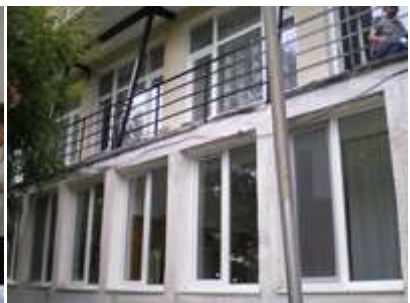
刷新された病棟の窓枠
