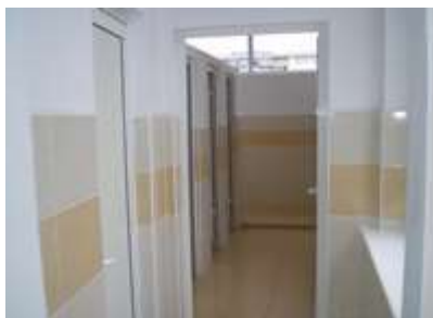
真新しくなった衛生施設
