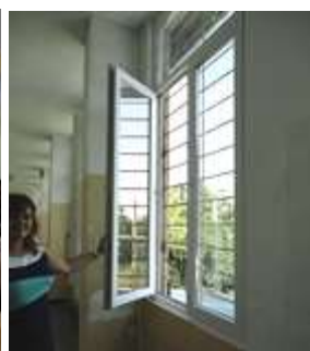
改善された窓枠
